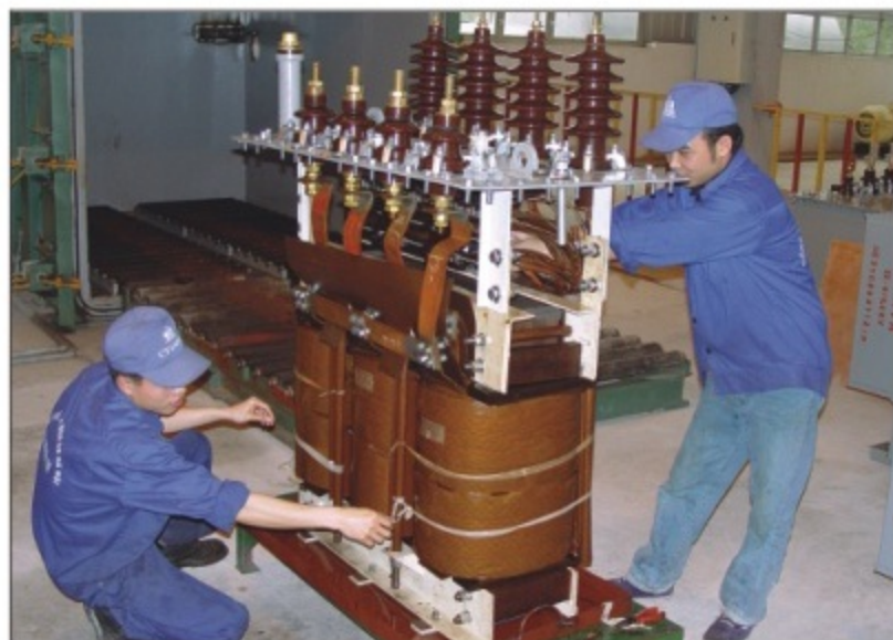
Lắp ráp máy biến áp Assembling transformer
