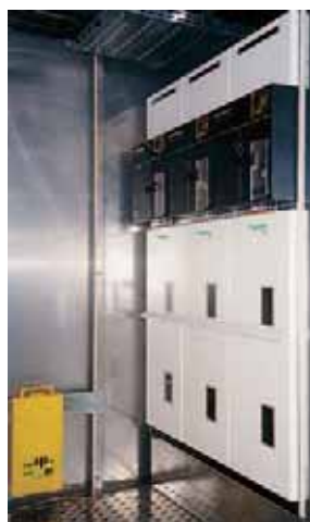
Lắp đặt tủ 400-630A trên chân đế 350mm
