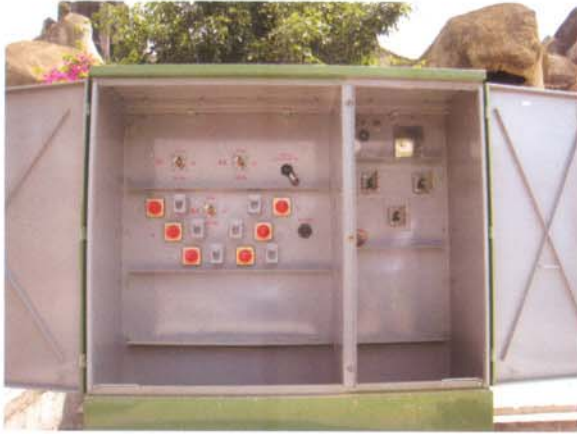
Máy biến áp hợp bộ Pad - mounted
